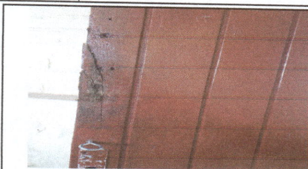
Foto 2: se cambiaran las puertas de madera por metal
