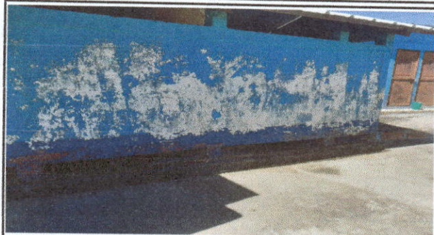
Foto 1: se pintaran las paredes con colores adecuados
